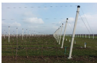
Konstrukcije na betonskim i drvenim stubovima
