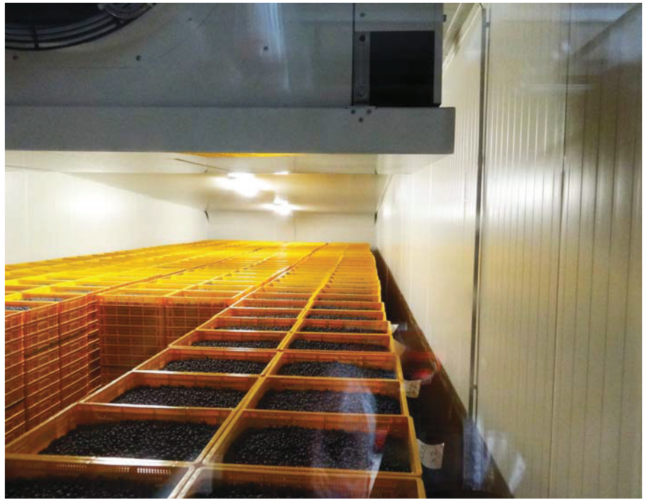
Abb. 8: Blick durch das Kontrollfenster eines Heidelbeer-CA-Raumes. Zur einheitlichen Umluftregelung wird ein fester Stapelplan, mit 10 cm Abstand zwischen den Palettenreihen und 20 cm Abstand zu den gasdichten Paneelwänden eingehalten. Der Ansaugkanal unter den Verdampfern hält 40 cm Wandabstand, der gegenüberliegende Druckkanal ist 50 cm breit. Die Räume sind mit schräg abfallender Decke - nach dem Standard der Niederelberegion gebaut. Die Stapelhöhe mit drei Paletten übereinander beträgt hier 6,20 m.
