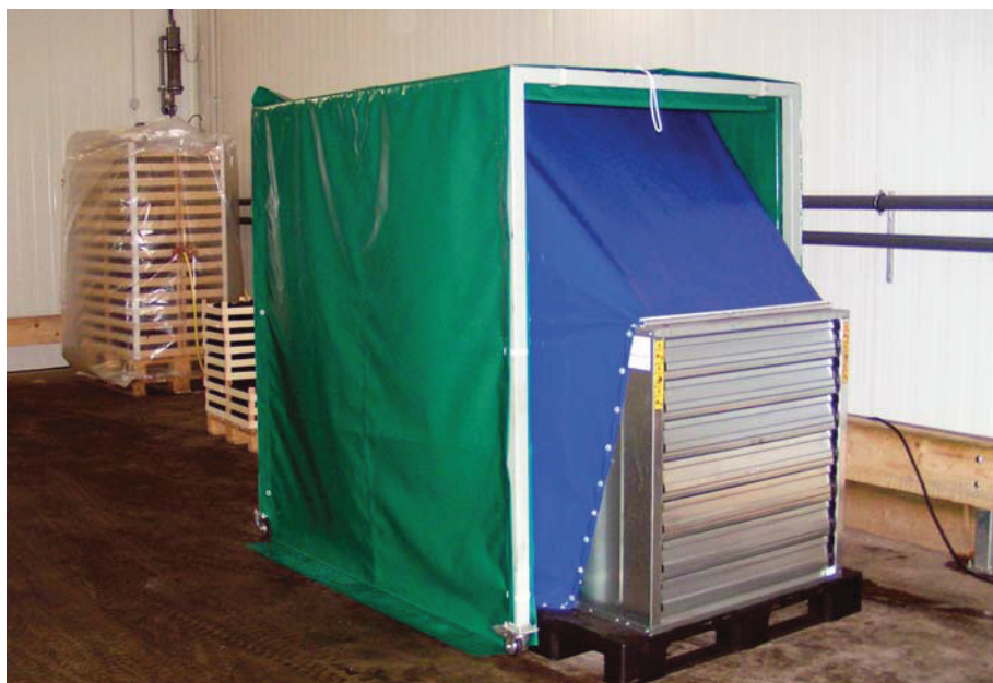
Abb. 1: Schnellabkühlung für einzelne Paletten: Ein starker Ventilator in trapezförmigen Dichtungsrahmen zieht bei diesem Eigenbau die kalte Raumluft durch die bis zu vier Paletten in einen verlängerbaren, hier grünen Luftkanal. (Fotos: Rolf Kirchhof)
