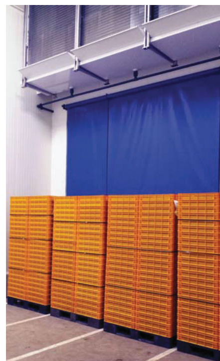
Abb. 2: Bei großen Erntemengen ist ein separater Schnellkühlraum mit variablen Rollos die effektivere Methode.
