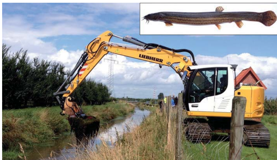
Abb. 1: Unter Schonung der Böschung und des Randbewuchses räumt der Bagger die Wetteren. Dadurch wird ihre sehr wichtige Aufgabe, die Funktionsfähigkeit der Entwässerung der umliegenden Obstbauflächen sicherzustellen, erhalten und trotzdem sind die Eingriffe in die Natur auf ein Minimum begrenzt. Kleines Bild: Europäischer Schlammpeitzger ( Misgurnus fossilis , Bildquelle: George Chernilevsky, Wikipedia, https://commons.wikimedia.org/w/index.php?curid=8528222 ). (Foto: Dirk Köpcke)
