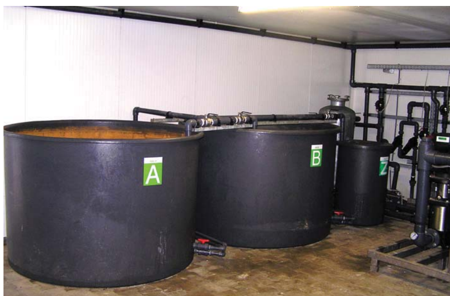
Abb. 15: Fertigungsanlage mit 2 Stammlösungsbehältern + 1 Säurebehälter.
